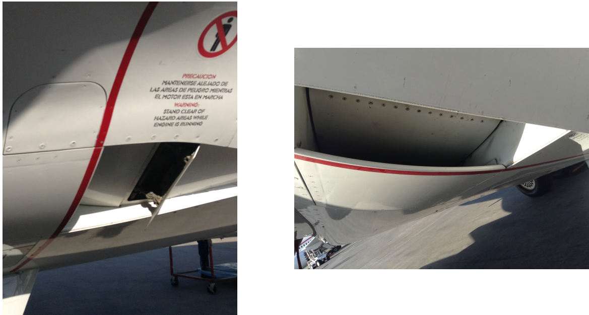
Figura 3.2: Lámina que permite ingreso al conducto de aire (izq.) y parte inicial del conducto de aire (der.).
